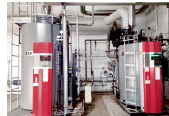
▲ 华润雪花啤酒沈阳工厂沼气回收利用系统
